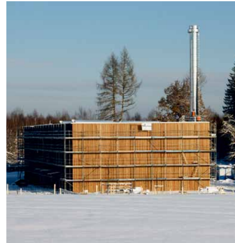
Hightech im Einsatz für die Grünwalder Fernwärmeversorgung und den Wärmeverbund mit Unterhaching: Das Geothermie-Heizwerk in Laufzorn ist im Einsatz.
