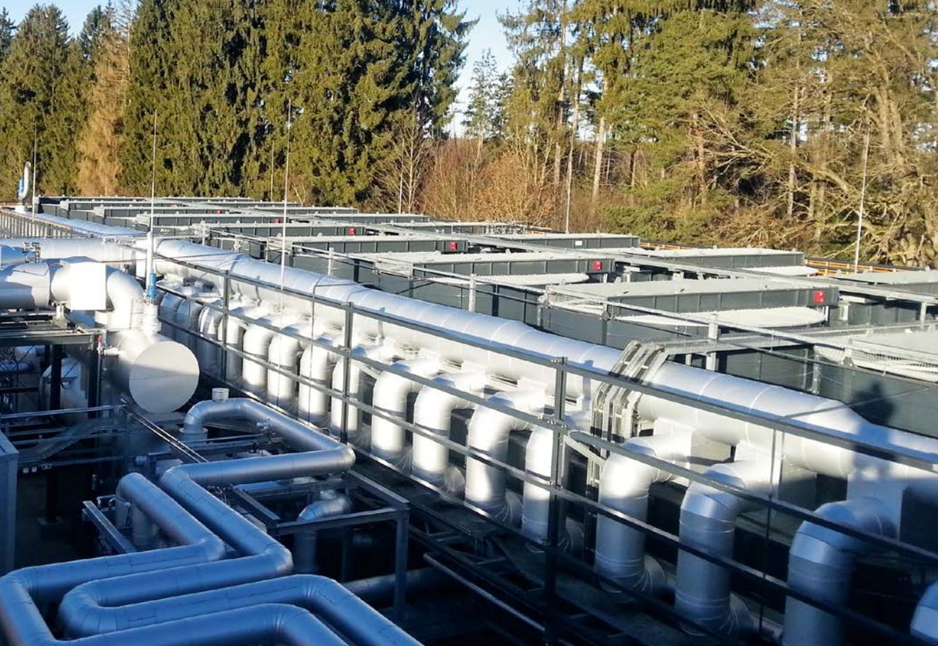
Das ORC-Stromkraftwerk der EWG in Laufzorn produziert grünen Strom – links das Turbinenhaus, rechts die Luftkondensatoren, kurz „Lukos“.
