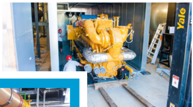
Anlieferung des Blockheizkraftwerk-Aggregats in Laufzorn
